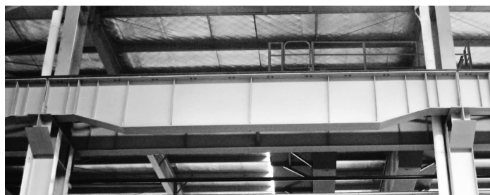
图 6 H 形截面的简支梁设计实例
