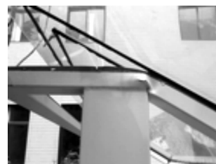
图10 腹板、翼缘板的失稳现象
