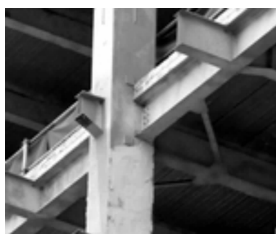
图8 钢结构框架梁端部隅撑
