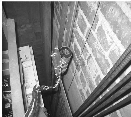
图 5 磁耦合器的安装照片
