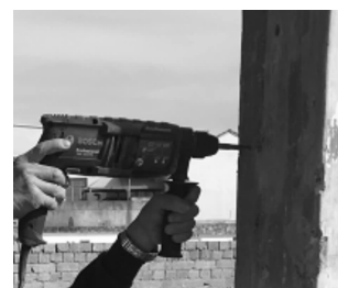
图2 冲击钻钻孔
